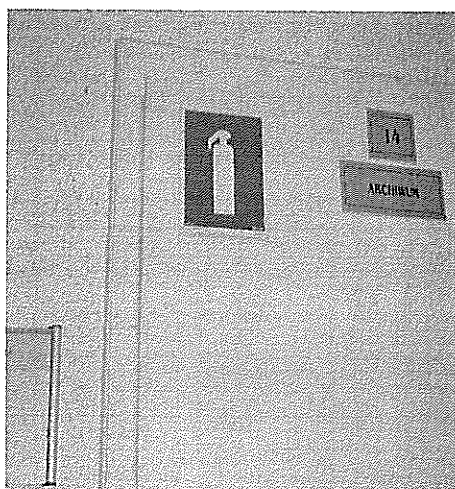
I Piętro – w pomieszczeniu archiwum
