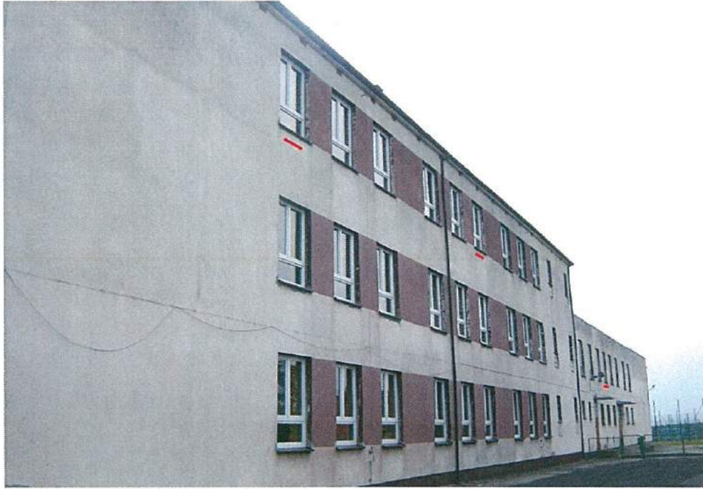
Foto. 16. Ściana nr 12 z zaznaczonymi miejscami gniazdowania jerzyka, widok od strony północnej Fot. Przemysław Kubacki
