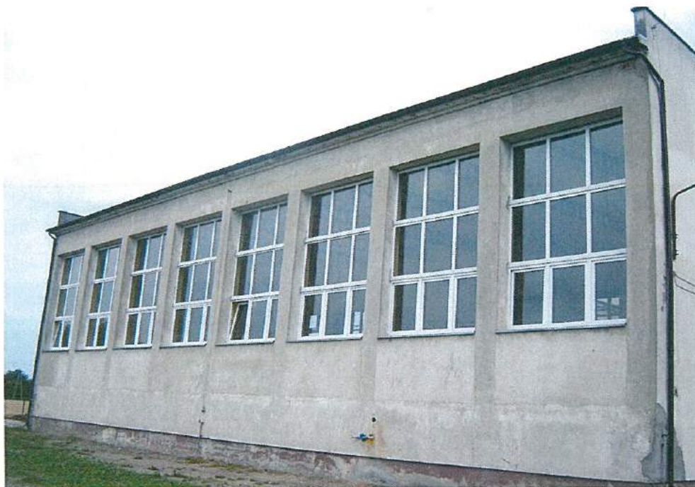
Foto. 14. Ściana nr 11, brak śladów gniazdowania Fot. Przemysław Kubacki
