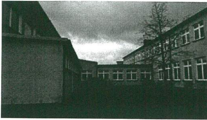
Fot. 10 widok elewacji szkoły od strony północnej – w środku łącznik
