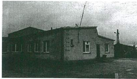
fot. 11 widok elewacji szkoły od strony południowej – parterowe przybudówki
