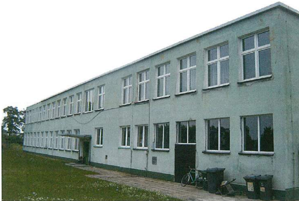
Foto. 7. Ściana nr 8, brak gniazdowania ptaków Fot. Przemysław Kubacki
