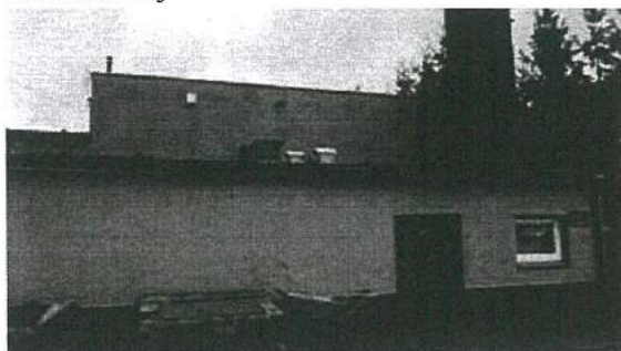
fot. 14 fragment elewacji południowej (kotłownia)
