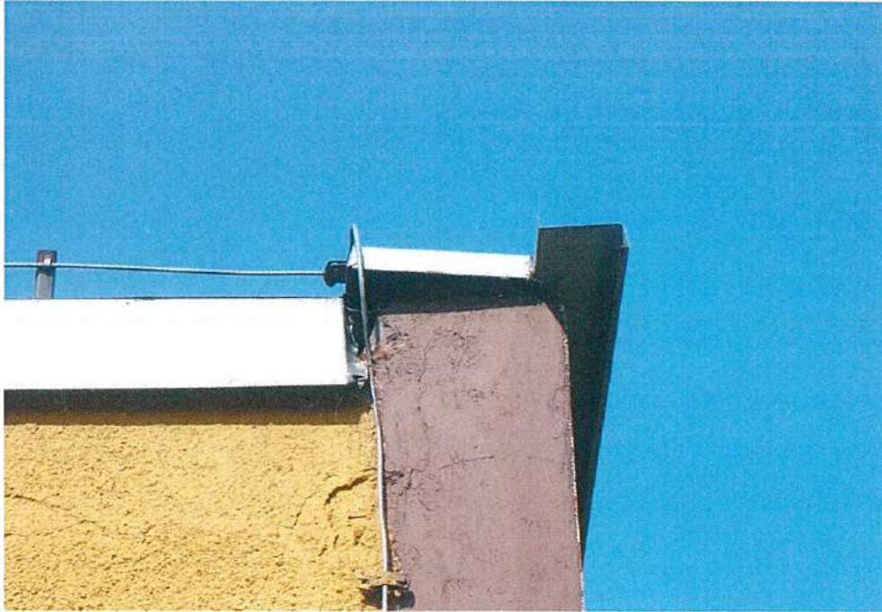
Foto. 12. Zbliżenie narożnika ściany nr 10 i 11, widoczny materiał do budowy gniazda Fot. Przemysław Kubacki
