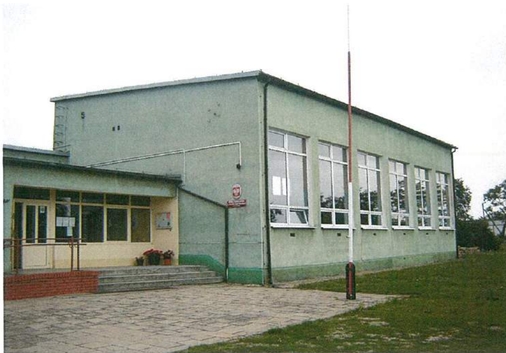
Foto. 1. Ściana nr 1 i fragment ściany nr 2 z wejściem głównym do budynku. Brak gniazdowania ptaków. Fot. Przemysław Kubacki
