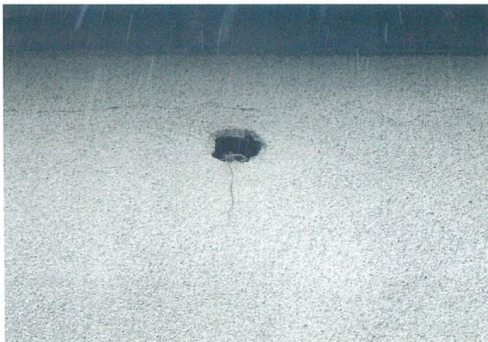
Foto. 6. Zbliżenie otworu w ścianie nr 4. Z otworu wystaje materiał budulcowy gniazda Fot. Przemysław Kubacki
