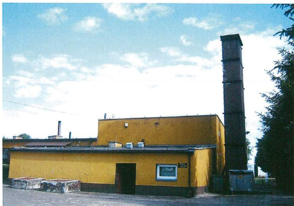
Foto. 1. Ściana nr 1, brak gniazdowania ptaków Fot. Przemysław Kubacki
