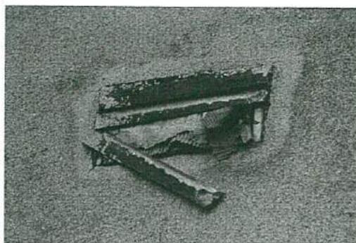
fot. 1 – 2 uszkodzone kratki wentylacyjne na budynku sali gimnastycznej – elewacja zachodnia
