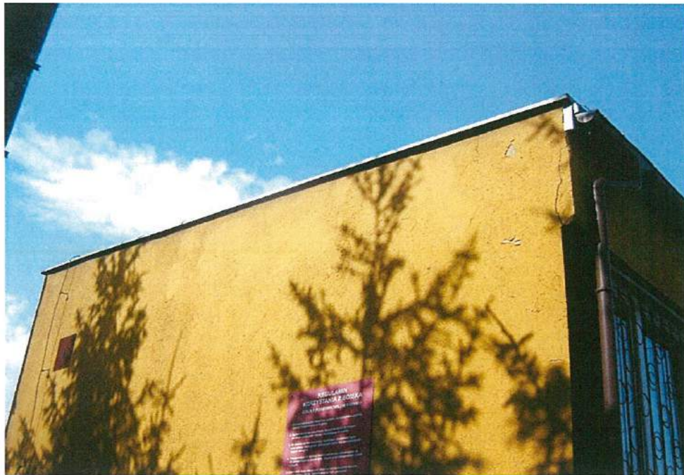
Foto. 14. Ściana nr 13, brak śladów gniazdowania Fot. Przemysław Kubacki
