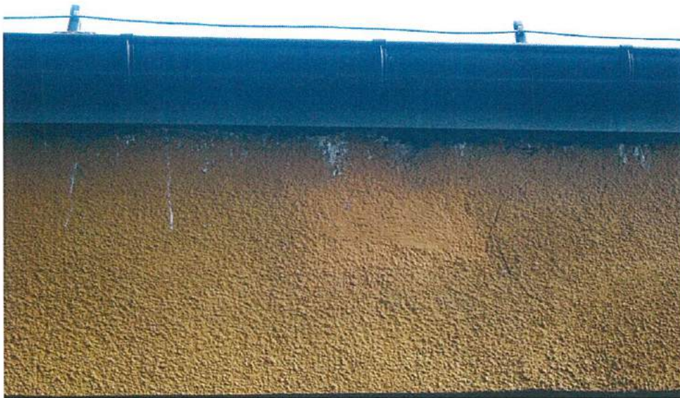
Foto. 4. Zbliżenie śladów gniazdowania nad czwartym od lewej oknem ściany nr 2 Fot. Przemysław Kubacki
