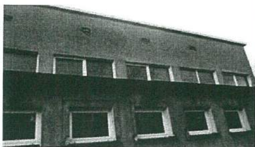
fot. 1 – 2 uszkodzone kratki wentylacyjne na budynku sali gimnastycznej – elewacja zachodnia
