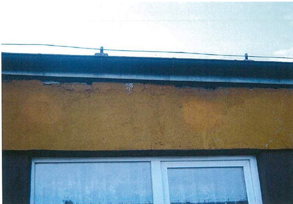
Foto. 7. Zbliżenie śladów gniazdowania nad trzecim od prawej oknem ściany nr 4 Fot. Przemysław Kubacki
