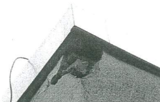
fot. 5 narożnik elewacji północnej z wyraźnymi ubytkami tynku
