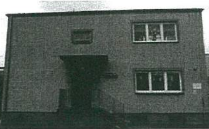
Fot. 6 wejście do budynku przedszkola
