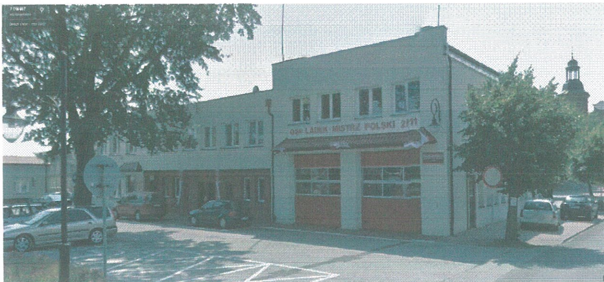
Zdjęcie nr 1 – ogólny widok budynku.
