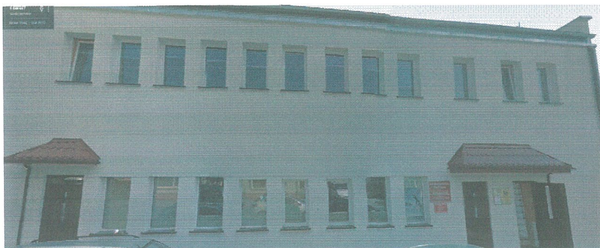
Zdjęcie nr 2 – widok elewacji części budynku ulegającej przebudowie.
